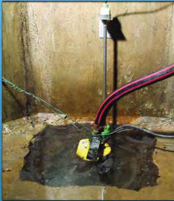
Messwertgeber NSQ in einer Schachtanwendung
