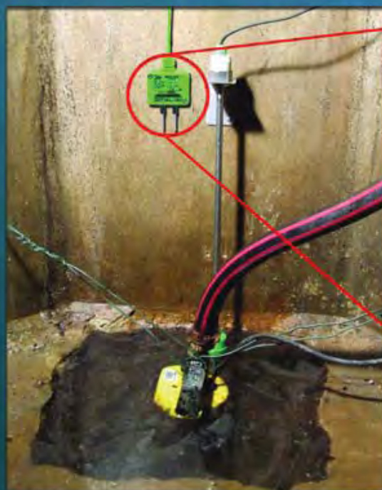
Wandelektrode WAE als zusätzlicher Alarmsensor im Schacht in kombinierter Anwendung mit einem Messwertgeber NSQ
